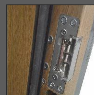
ELEKTROZACZEP ZAMONTOWANY W OŚCIEŻNICY TERMO ODS65 i TERMO ODS68
